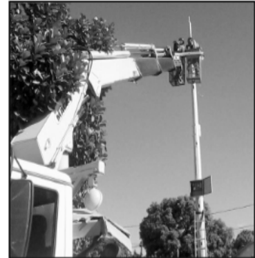
No último sábado (15), uma equipe técnica iniciou as instalações das câmeras de videomonitoramento, no bairro Aviso, em Linhares. Uma das câmeras (foto) foi instalada no cruzamento da Avenida Paraná e Rua Pernambuco.
