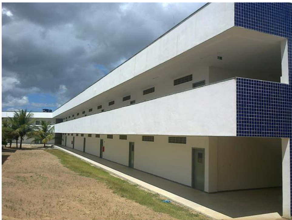
Fig. AIV-12 – Novo Bloco de Ensino, em fase de adaptações para utilização.
